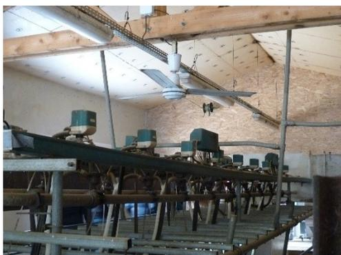
Exemple de brasseur d'air dans une salle de traite, couplé à un fil collant.
